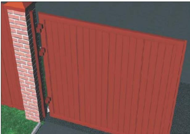
1. Поднесите створку к столбу. С помощью подкладок обеспечьте горизонтальность положения створки и необходимый просвет.
