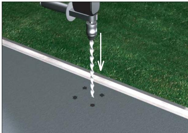
2. Просверлите 4 отверстия  $\text{Ø}13$  в дорожном покрытии.
