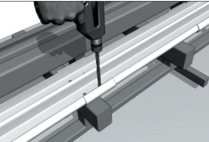
Просверлите отверстия  $\varnothing 7$  мм для крепления кронштейна соединительного для сдвоенных направляющих.
